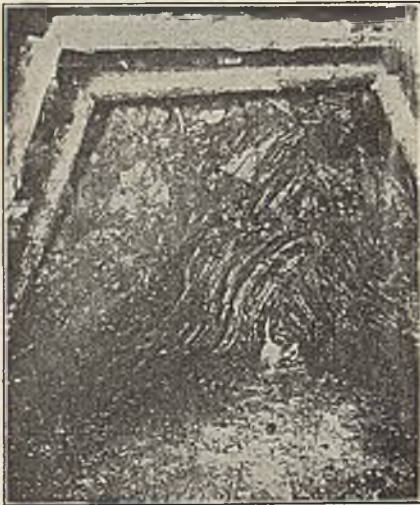
Abb. 7. Aufwölbung des Liegenden unter Verlängerung der Schichten in Kladno (Böhmen).
