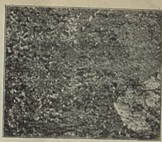
Abbildung 22. Graphitansatz zerfressener Koks- ofenwände, Beschickungsseite.
