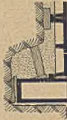
Abb. 1. Fuß eines mit englischen Tübbingen ausgekleideten Schachtteiles.
