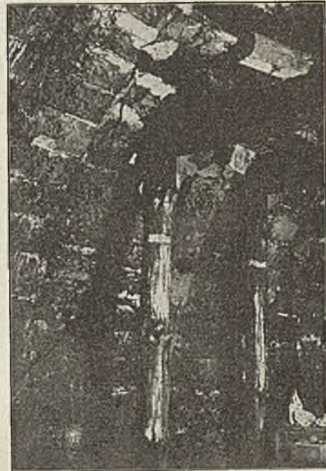
Abb. 13. Ausbau mit Ruhrsandsteinen.
