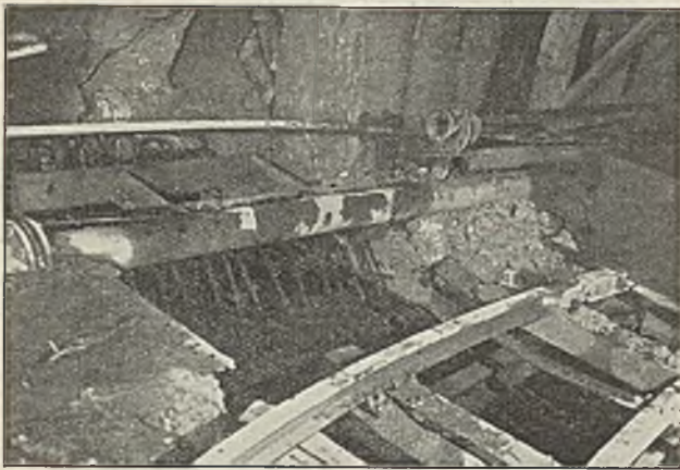
Abb. 5. Vergießen der Sohle beim Dreigelenkbogenausbau.
