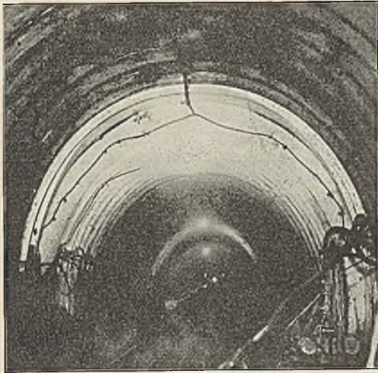
Abb. 11. Fertiggestellte Strecke im Dreigelenkbogenausbau.
