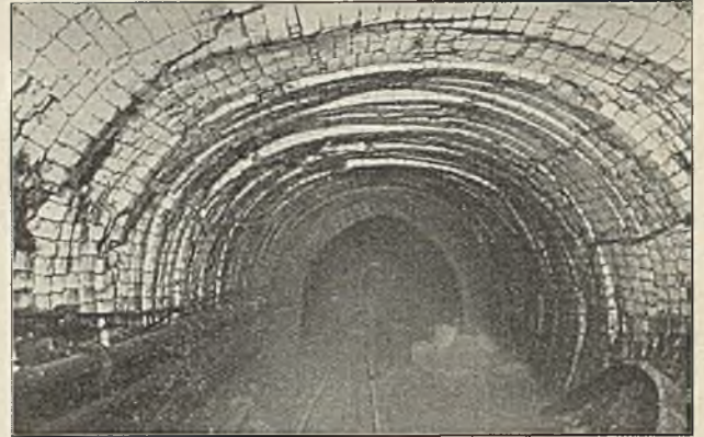
Abb. 3. Betonplattenausbau.
