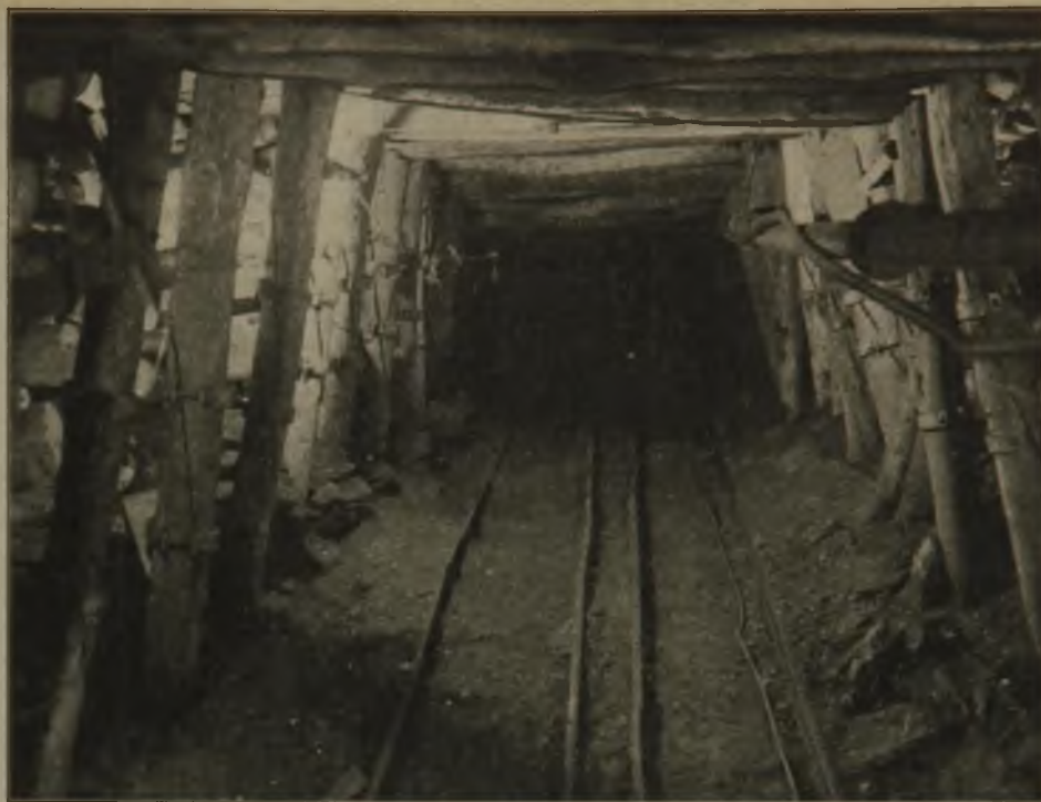
Streckenausbau mit Stempeln, die nach dem Verfahren von Heidkamp hergestellt sind.
