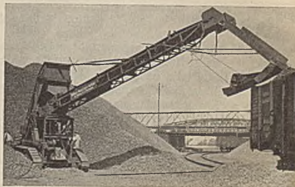
Abb. 1. Fahrbares Becherwerk der Firma Dolberg in Dortmund.
