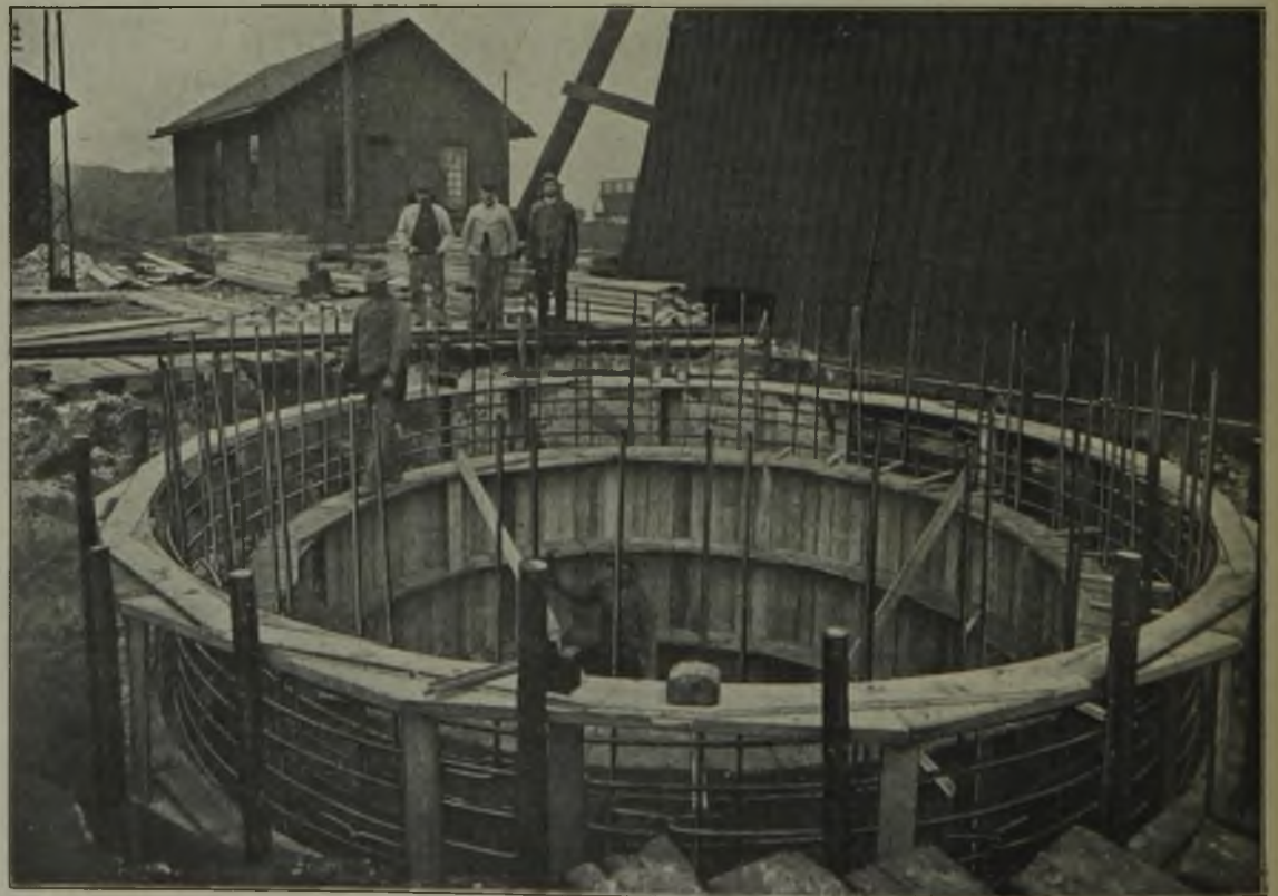
Abb. 4. Ansicht des Schachtes während der Herstellung des Schachtringkörpers.
