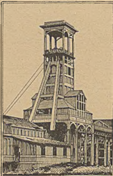
Abb. 20. Fördergerüst mit Wetterschleuse auf Schacht 2 der Gesellschaft Hensis-Pommeroeul.
