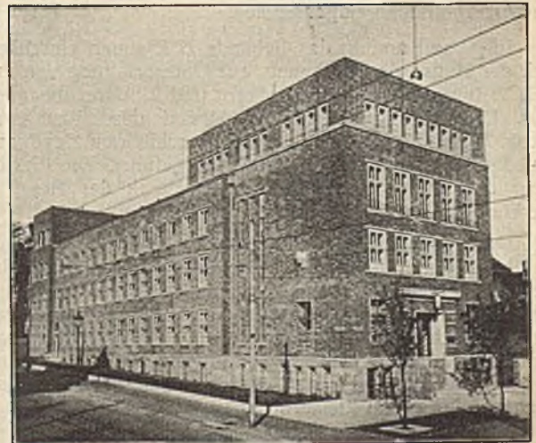
Abb. 1. Ansicht des Gebäudes.
