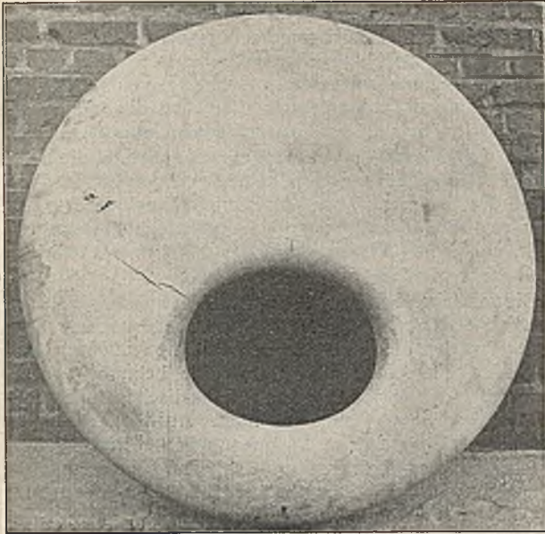
Abb. 1. Lage des Risses.
