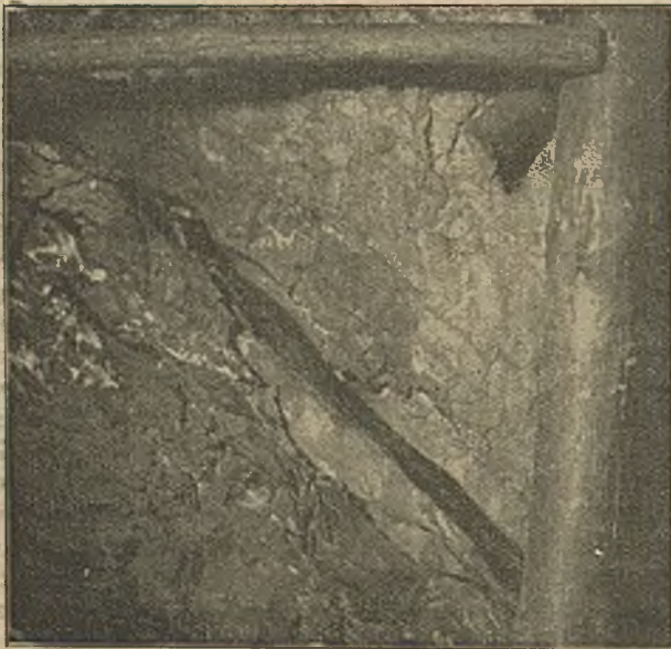
Abb. 2. Gebirgskluft zwischen Schiefer und Sandstein in einem Ortsquerschlag über einem abgebauten Flöz.
