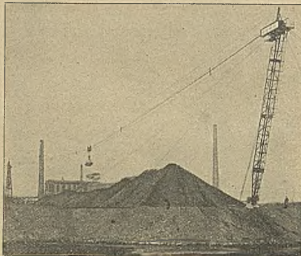
Abb. 8. Mast am Ende des Kokslagers.
