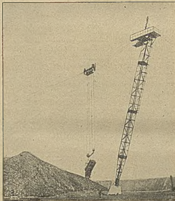
Abb. 3. Kabelmast am Ende des Kokslagers.
