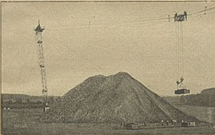
Abb. 17. Rückverladung des Koks vom Lager auf den Rheinbabenschächten.
