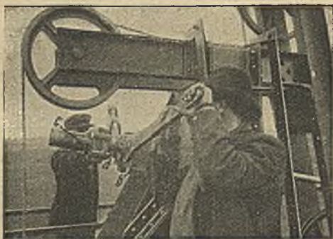
Abb. 9. Vornahme der Seilspannung.
