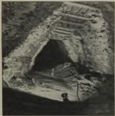
Abb. 2. Blick vom Kohlenstoß in ein Entspannungsort.
