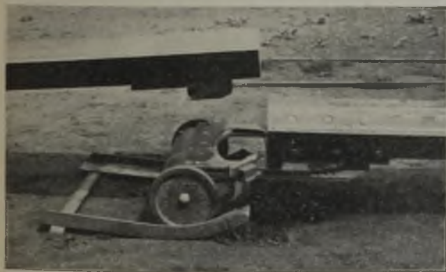
Abb. 8. Ansicht der schraubenlosen Verbindung von Vedder mit Rollensatz und Rollenbock.
