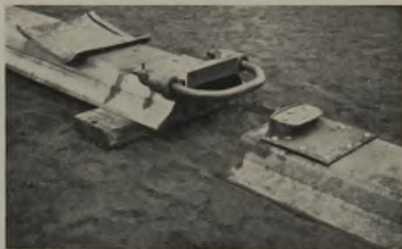
Abb. 2. Bügelschraubenverbindung der Firma Hauhinco.
