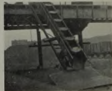
Abb. 2. Kettenbremsförderer.
