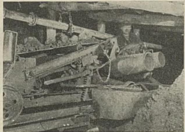
Abb. 4. Blasversetzer mit Doppelrohr.
