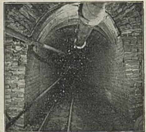
Abb. 3. Ziegelsteinmauerung mit Quetschholzeinlagen in der Umtriebstrecke von Schacht 5 zur östlichen Richtstrecke.
