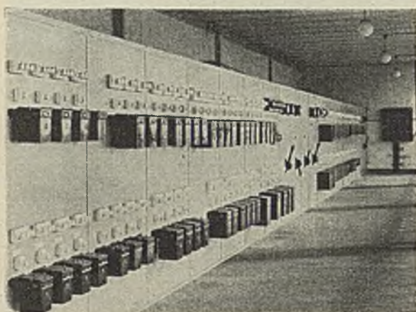
Abb. 15. Neuzeitliche Schaltanlage.
