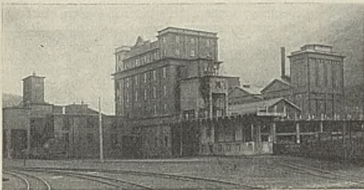
Abb. 5. Brikettanlage, Wäsche und Kraftzentrale des Bergwerks Rtanj.
