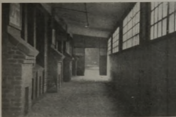
Abb. 8. Aushängung seitlich der Marschrichtung, besonders aber zwischen Fenstern ist unzweckmäßig.
