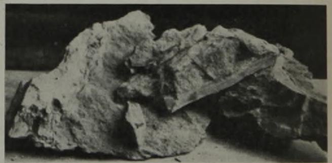
Abb. 8. Mit Zement ausgefüllte Spalte.
