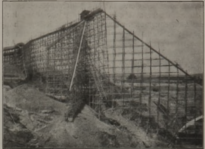
Abb. 5. Schleusenkastengestell einer Grube des Kinta-Tales. Eine Pumpanlage drückt das Gut aus der Grube herauf.
