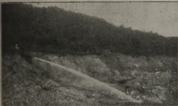
Abb. 4. Monitorbetrieb in den Gruben der Dänischen Ostasien-Gesellschaft bei Pong.
