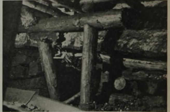
Abb. 14. Abreißen der Deckschichten nahe am Stoß.
