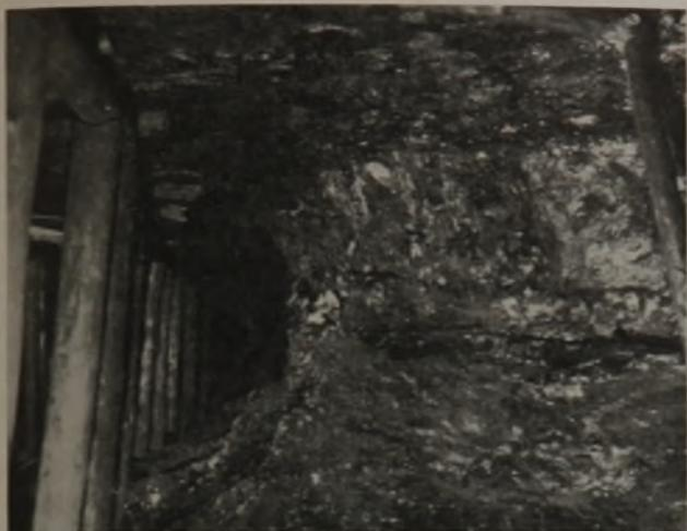
Abb. 6. Vorauseilen der Deckschichten mit Bildung von in den Stoß hinein fallenden Drucklagen.
