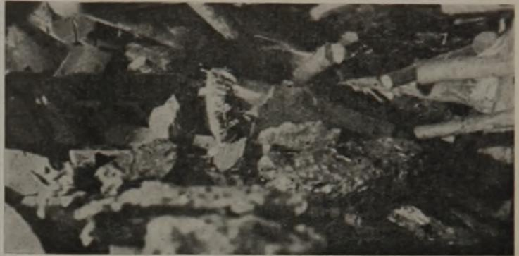
Abb. 11. Abbrechen des Hangenden hinter den Holzpfeilern.
