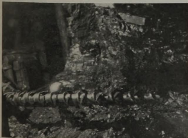
Abb. 7. Vorauseilen der Sohlen- und Deckschichten mit Bildung von zweierlei Drucklagen.
