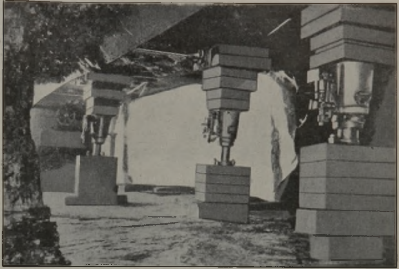
Abb. 9. Verbindung von hydraulischen Stempeln mit Hartholzkasten.
