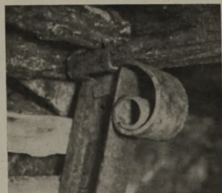
Abb. 1. Neu eingebaute Eckverbindung.
