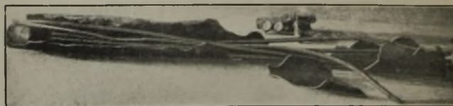
Abb. 2. Wirkungen der Explosion.
