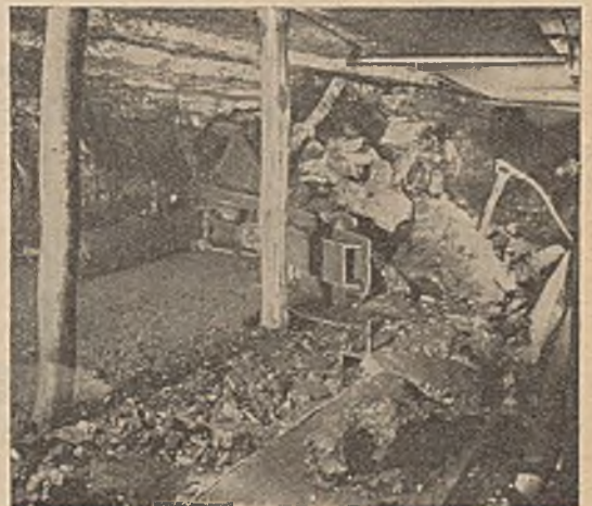
Abb. 14. Der Abbaupflug im Einsatz untertage.
