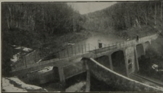
Abb. 1. Ansicht des Stauwerks.
