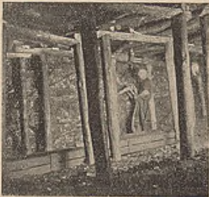
Abb. 15. Blick in das Abbaufeld in Flöz Karl.
