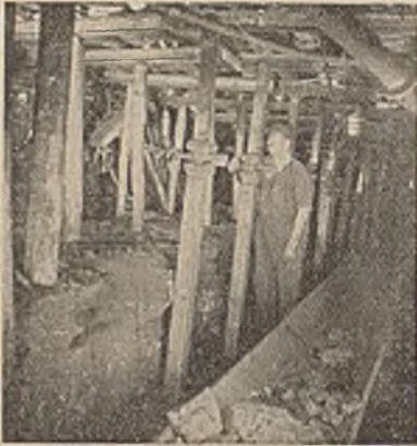
Abb. 10. Blick in das Abbaufeld in Flöz Sonnenschein.
