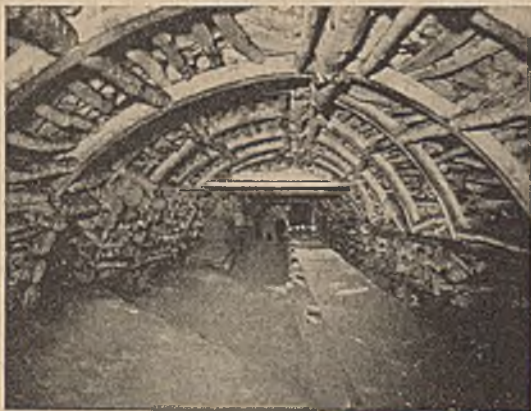
Abb. 7. Abbaustrecke in Flöz Dickebank.
