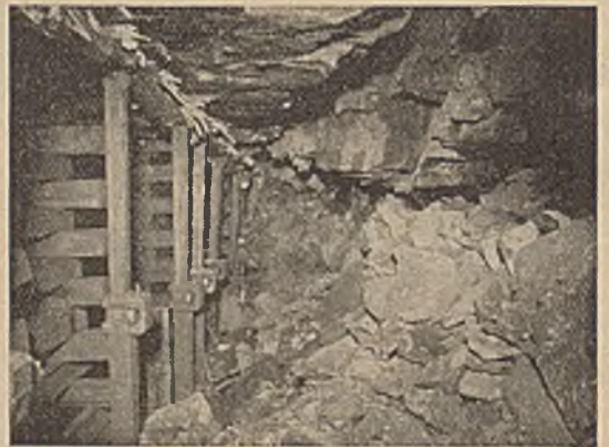
Abb. 6. Das Bruchfeld in Flöz Dickebank.
