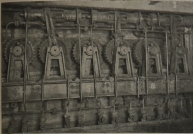
Abb. 9. Mittelteil des Schwelofens mit den Walzenantrieben.
