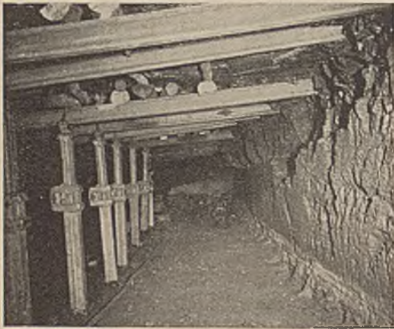
Abb. 17. Abgepflühtes Feld. Mittelstempel unter den vorgepfändeten Kappen.
