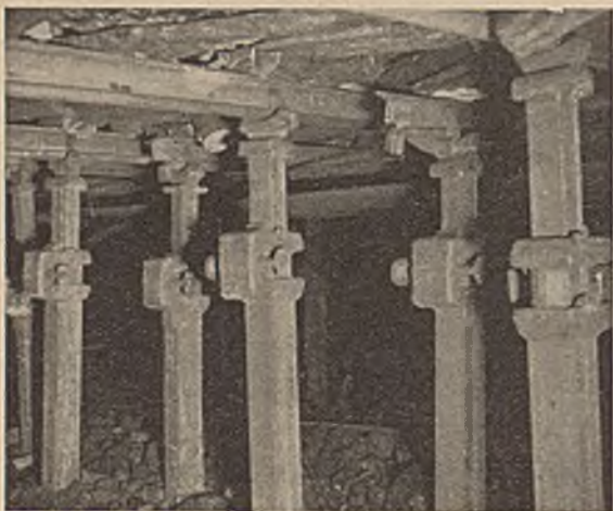
Abb. 18. Mittelstempel des alten und Endstempel des neuen Feldes.
