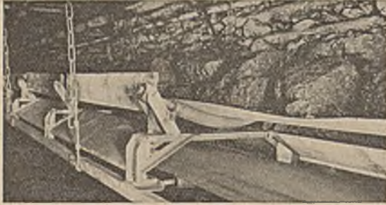
Abb. 1. Ansicht der Stahlmuldenbandanlage.
