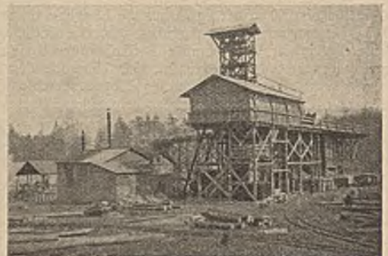
Abb. 7. Fördereschacht und Übertageanlagen einer Toneisensteingrube. Grube Wiktorja bei Chlewiska.
