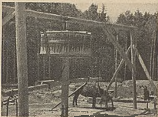
Abb. 8. Schachtabteufen mit Pferdegöpel auf einer Toneisensteingrube. Grube Stanislaw bei Staporków.
