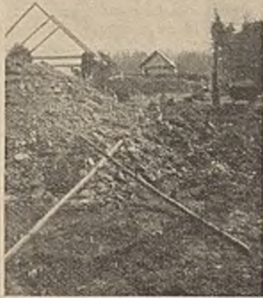
Abb. 5. Reihenanzordnung von Duckelschächten. Grube Helena bei Chlewiska.
