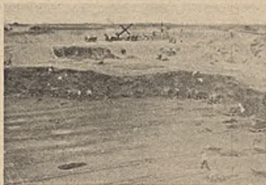
Abb. 10. Tagebaubetrieb auf Brauneisenerz. Abraumgewinnung mit Baggerbetrieb. Grube Mikolaj bei Tychow.
