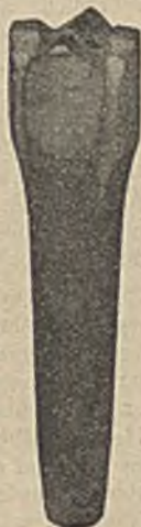
Abb. 11. Hartmetallschlagbohrer mit 212 m Bohrleistung in konglomeratischem Sandstein.
