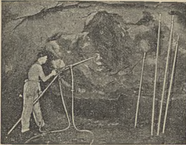
Abb. 2. Handbohrhammer mit Stütze.
