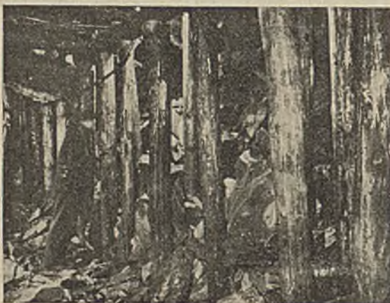
Abb. 24. Stribbruchbau ohne Wanderkästen auf Holzstempeln bei 2,60 bis 3,20 m Mächtigkeit, Gabriele-Schacht, Olsagebiet.
