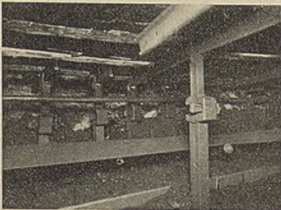
Abb. 11. Zwei Brechstempel zwischen dem streichenden Ausbau bei günstigen Hangendverhältnissen, Grafia-Johanna-Schacht.
