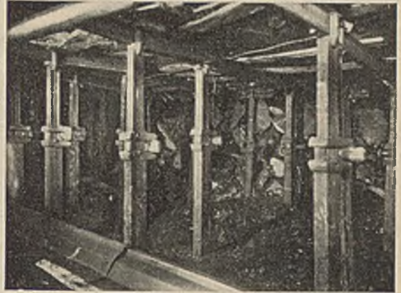
Abb. 21. Der Hilfsstempel in der Doppelreihe am Bruchfeld bei 2,10 m Mächtigkeit, Oheimgrube, Kattowitz.
