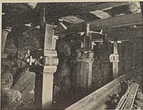
Abb. 20. Die weitgesetzte Doppelreihe bei schwierigen Verhältnissen und steilem Einfallen, Grube Knurów, Ost-O.-S.
