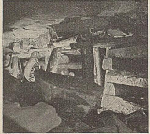
Abb. 9. Bruchkante der untersten Dachschicht hinter den Holzpfählern in Flöz 1.
