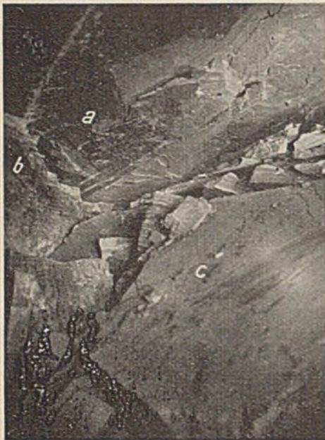
a anstehendes Haupthangendes, b Bruchfläche der anstehenden Dachschichten, c Haufwerk der niedergebrochenen Dachschichten.
