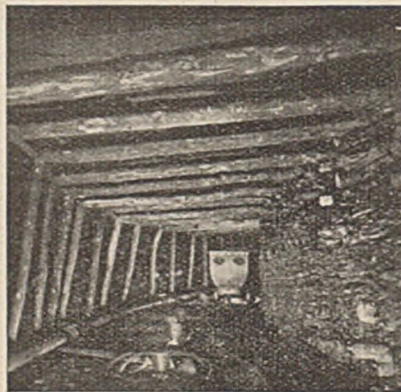
Abb. 31. Abbaustrecke in Betrieb.
