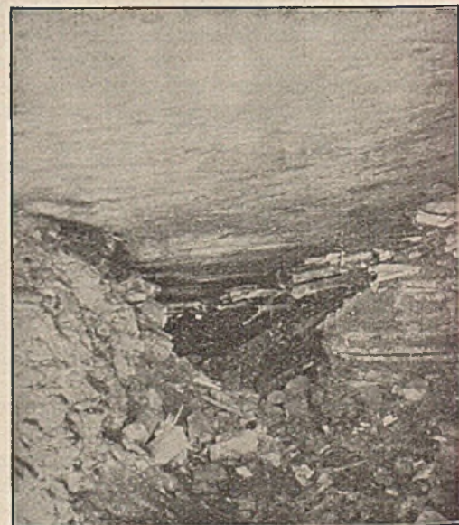
Abb. 32. Abgeworfene und ausgeraubte Abbaustrecke nach 1 Jahr.
