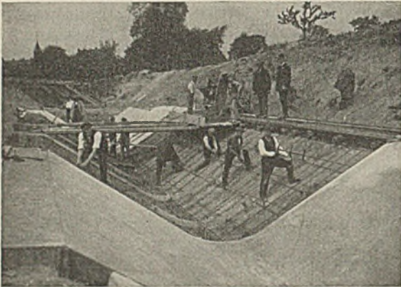
Abb. 3. Überbrückung der Bruchstellen mit einer Eisenbetonrinne.
