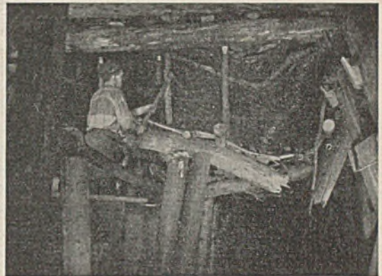
Abb. 41. Schieferungserscheinung an bankigem Tonschiefer in einer Abbaustrecke des Schachtes Gottes Hilfe in Lugau.
