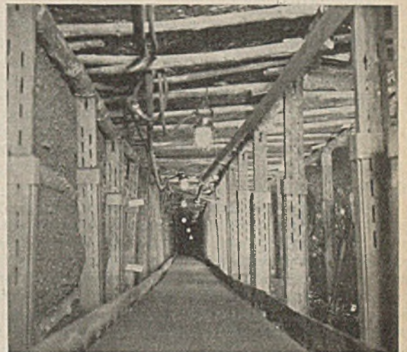
Abb. 5. Vorwärts- und rückwärtslaufendes Strebband.
