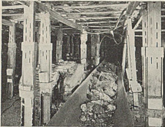
Abb. 6. Schüttelrutsche mit seitlich stehender elektrischer Antriebsmaschine.
