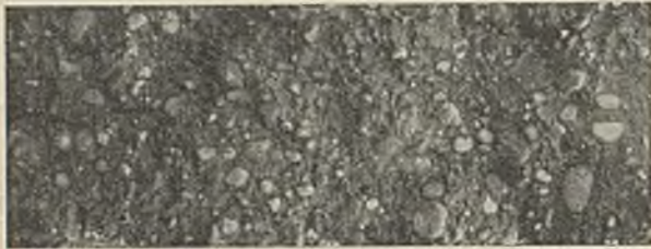
Abb. 6. Bruchfläche des frischen, fünf Tage alten Betons.
