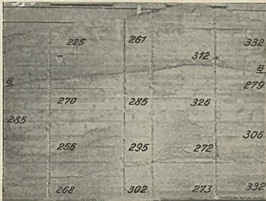
Abb. 8. Ausgeschaltete Betonwand nach Entfernung des obersten Teils (die senkrechten Kerben sind nachträglich angerissen; die eingetragenen Zahlen bedeuten die Würfel-druckfestigkeit an den betreffenden Stellen in kg/cm 2 ).
