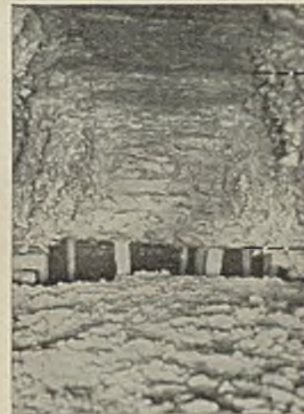
Abb. 6. Schieferung des Hangenden durch den Abbau.
