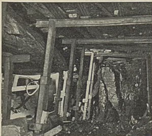
Abb. 4. Abreißen des Hangenden an der Drucklagenrichtung 1 in Flöz Röttgersbank.
