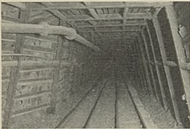
Abb. 16. Mit Kappeneisen und Kappwinkel neu ausgebaute Strecke.
