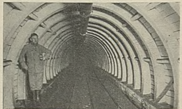
Abb. 18. Ausbau in Eisenbetonrippen.
