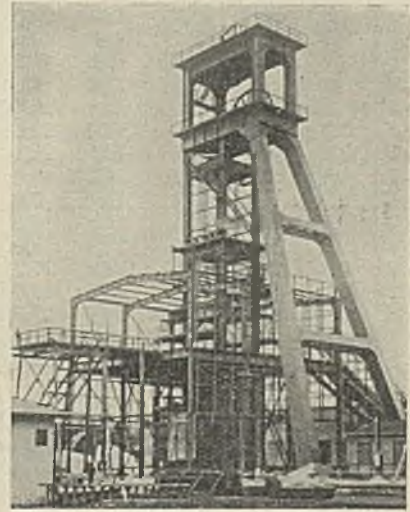
Abb. 7. Ansicht des Fördergerüsts.
