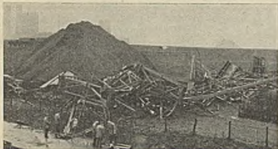
Abb. 2. Umgestürzte und zerstörte Brücke.
