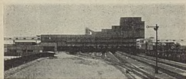
Abb. 2. Ansicht der Aufbereitungsanlage von der Bahnhofseite.
