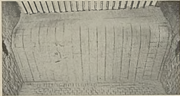
Abb. 10. Verbesserte Ausführung der Hängedecke in Abb. 9 nach gleicher Betriebsdauer.
