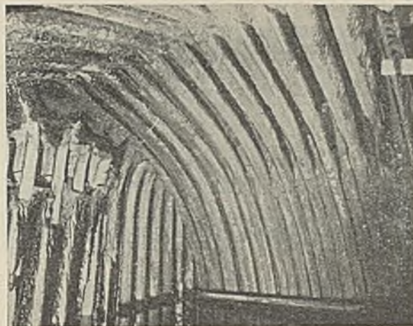
Abb. 8. Decke eines Strahlungskessels.
