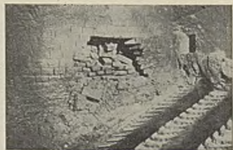
Abb. 5. Vorschubmuldenrostfeuerung.
