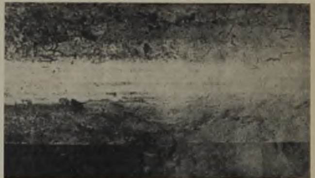
Abb. 9. Oberfläche einer schlechten Schienenauftragschweißung.
