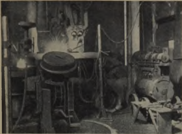
Abb. 6. Automat bei Bandagenaufschweißung.
