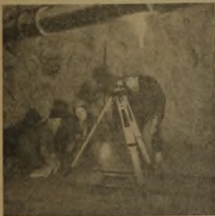
Abb. 4. Reststückmessung mit optischem Lot.
